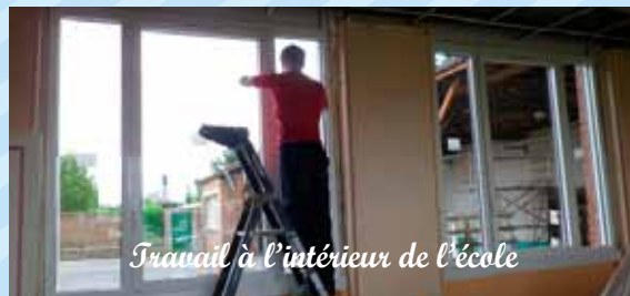
Montage d'un profilé par les ouvriers de l'entreprise Seeuws
