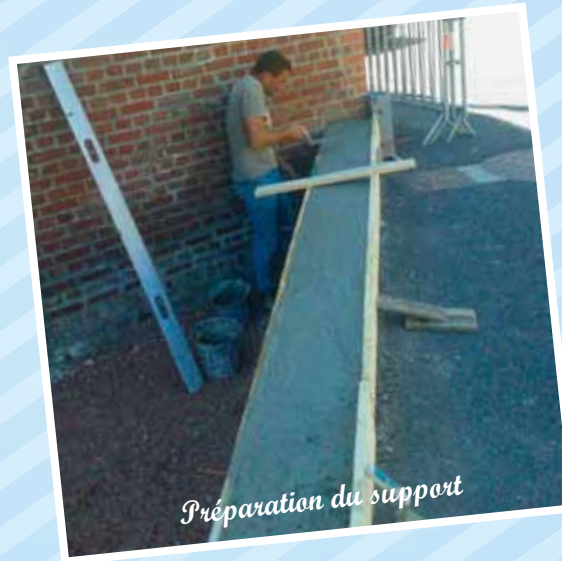
Préparation du socle pour l'installation des grilles de protection.
