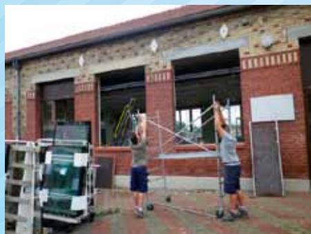
Démontage des grilles de protection
